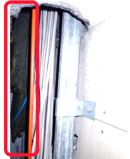
Kuva 19. Ilmavirtausten myötä mineraalivillaisissa tilkkeissä oli nähtävillä tummentumaa (kuvassa villatilkettä rajattu punaisella)
