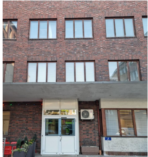
Kuva 3. Toimistohuone 101 sijaitsee ulosvedetyllä osalla, kuvan oikeassa reunassa. Sisäpihan puolella on muutaman metrin syvyinen katos, jonka sadeveden poisto tapahtuu syöksyputken kautta tilan 101 vierellä.
