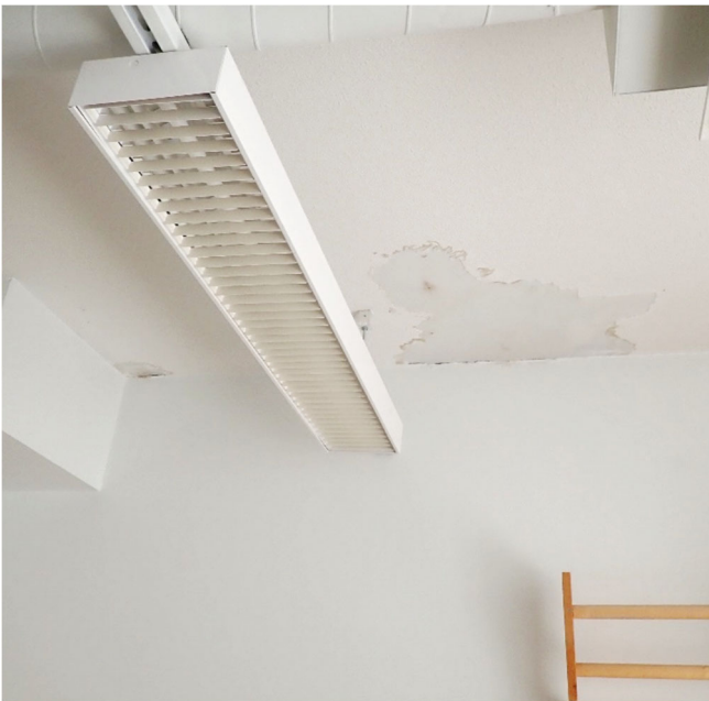
Kuva 4. Tilassa 109 katon vanhojen kosteusjälkien kohdalla pintakosteus oli hieman koholla muuhun kattoon nähden.
